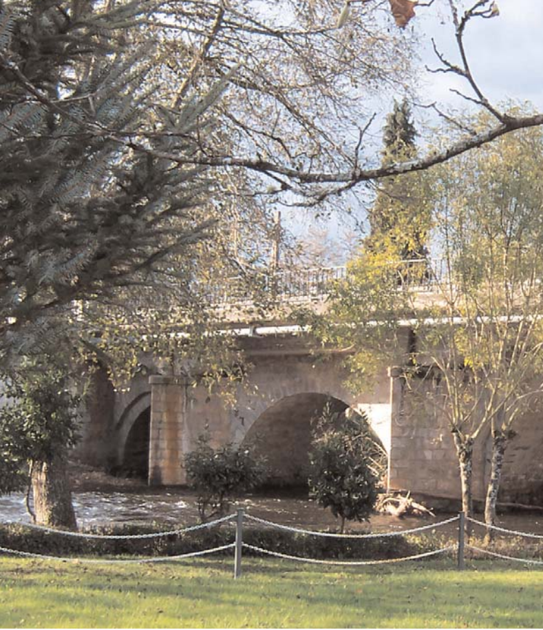
Ponte Sigüeiro sobre o Tambre
