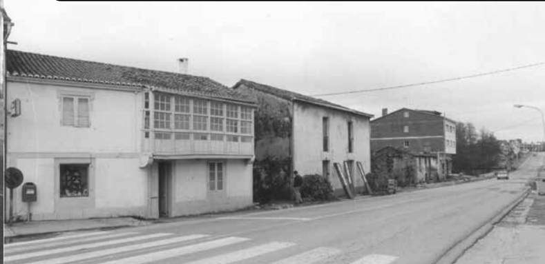
Vista en dirección A Coruña. En primeiro termo, a casa de Estrella Rico (con galería) e a de Eduardo Rico (do serradoiro, que foi destruída). Ao fondo, un edificio que se conserva na actualidade.
