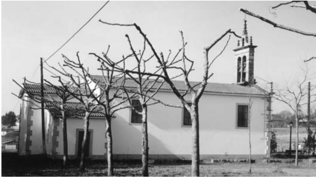
VILARROMARIZ | Igrexa parroquial de San Tomé, construción recente que aproveita a espadana e as imaxes da igrexa anterior.
