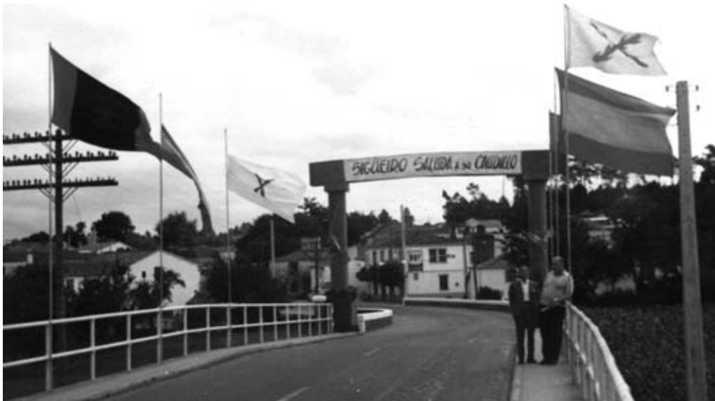
SIGÜEIRO | Vista da ponte engalanada con motivo da pasaxe do ditador Franco.
