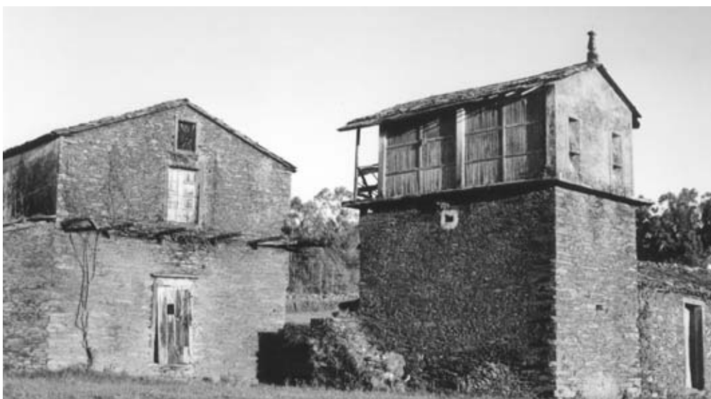
ANXOS | Hórreo de tres andares na casa de Mañá en Bran, edificado no ano 1948.
