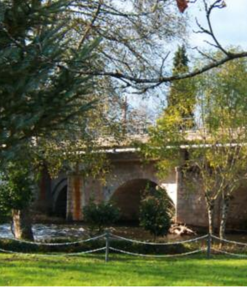
Sigüeiro Bridge, over the Tambre
